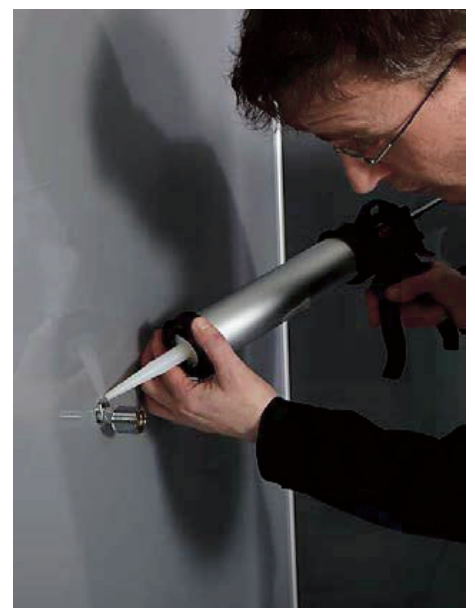
3.20 Durchführungen mit essigsäurefrei vernetzendem Naturstein-Silikon abdichten
