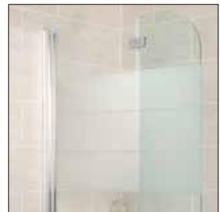
8) Jetzt kann die Badewannenfaltwand eingesetzt und ausgerichtet werden. Diese wird von innen mit dem Profil verschraubt. Nun wird nur noch die Dichtung angebracht. FERTIG!
