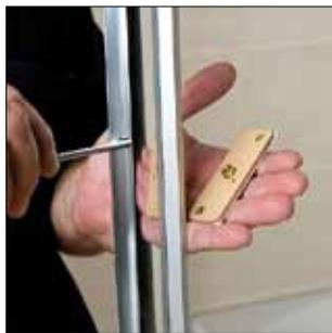
2) Um die Adapter optimal platzieren zu können müssen zunächst die beiden Profile mit dem Adapter verbunden werden. Dann wird der Randabstand des Profils an der Fliese markiert.
