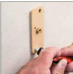
5) Jetzt wird geklebt. Die Tube wird aufgestochen und mittels der Aufrollhilfe wird zunächst die untere Öffnung solange befüllt bis es an der Kontrollöffnung wieder austritt. Dieser Vorgang wird mit der oberen Öffnung wiederholt.
