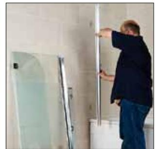
4) Die Profilkombination wird vom Adapter gelöst und durch das Heraus-schrauben wird gleichzeitig der Adapter an der Wand fixiert.
