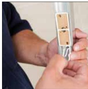
3) Entfernen Sie die Schutzfolie des Doppelklebebandes an dem Adapter. Mit Hilfe einer Wasserwaage wird das Profil an der Wand positioniert.
