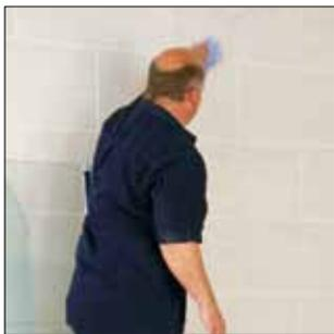
1) Die Montage der Badewannenfaltwand ist ganz einfach. Zuerst muss die Fläche von Schmutz und Staub befreit werden. Wischen Sie die Fläche mit einem sauberen trockenen Tuch ab.
