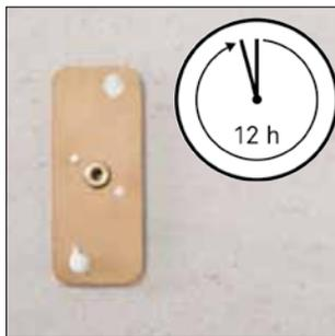
6) Der Kleber muss nun mindestens 12 Stunden aushärten. Nach Ablauf der Aushärtezeit werden die Kleberreste mit einem Messer abgeschnitten.
